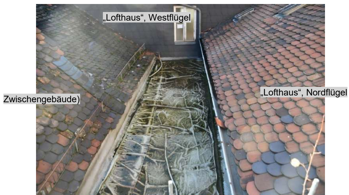
Bild 36: Flachdach, Blickrichtung West (23.11.2022)
