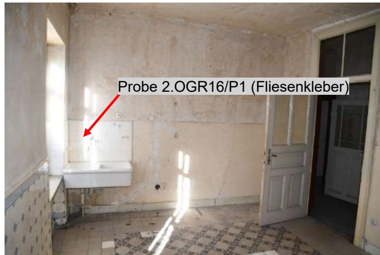
Bild 20: 2. OG Raum Nr. 16, Blickrichtung Nord (23.11.2022)
