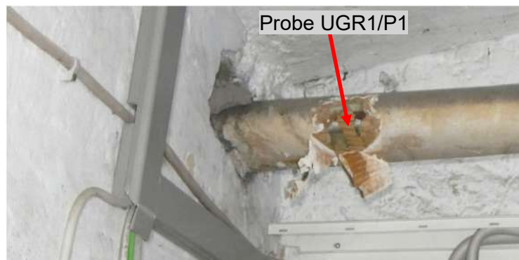
Bild 5: Rohrisolierung (Steinwolle) in Kellerraum Nr. 1 (29.11.2022)
