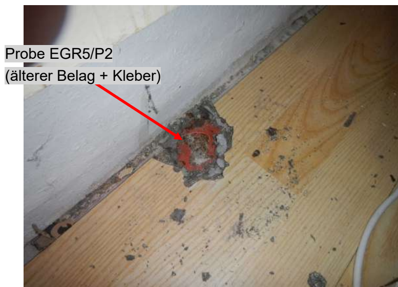
Bild 28: EG Raum Nr. 5, Fußbodenaufbau (29.11.2022)
