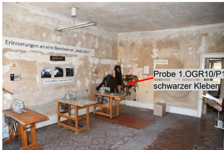
Bild 11: 1. OG Raum Nr. 10, Blickrichtung Südwest (23.11.2022)
