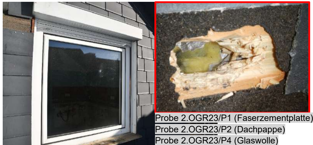
Bild 26: Westfassade „Der Heinrich“ im Bereich des Balkons (23.11.2022)
