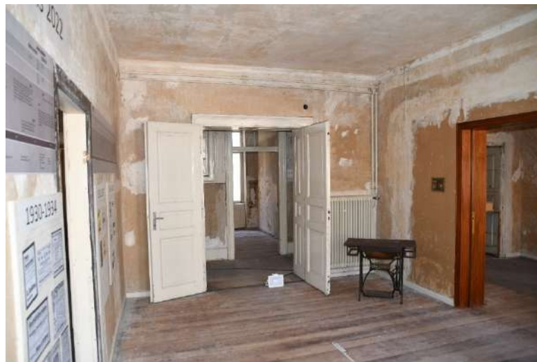
Bild 10: 1. OG Raum Nr. 9, Blickrichtung West (23.11.2022)
