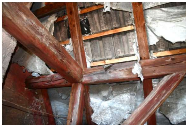
Bild 34: Spitzboden Raum Nr. 2, Detail des Dachstuhls (23.11.2022)
