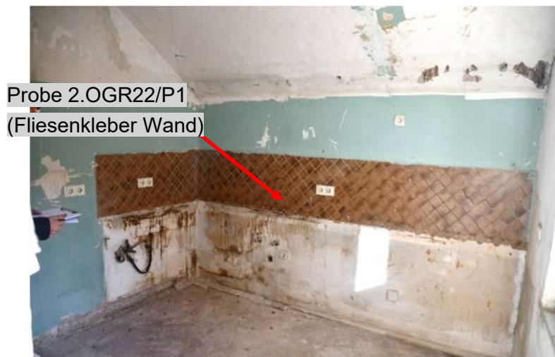
Bild 32: 2. OG Raum Nr. 22, Blickrichtung Süd (23.11.2022)
