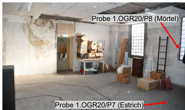
Bild 46: 1.OG Raum Nr. 20, Bereich Ost (23.11.2022)
