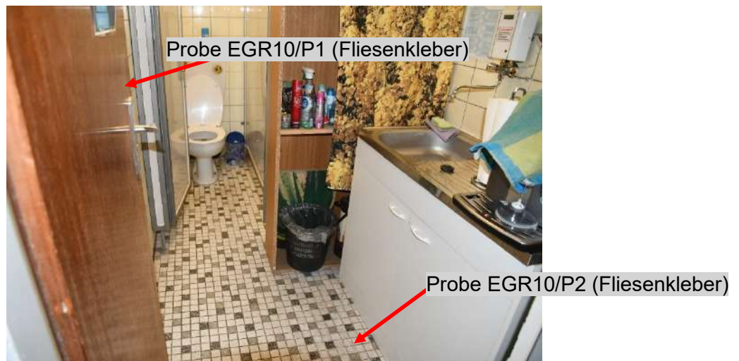
Bild 38: EG Raum Nr. 10, Blickrichtung Nord (23.11.2022)
