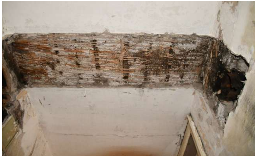
Bild 13: 1. OG Raum Nr. 3, Putzaufbau Decke (23.11.2022)
