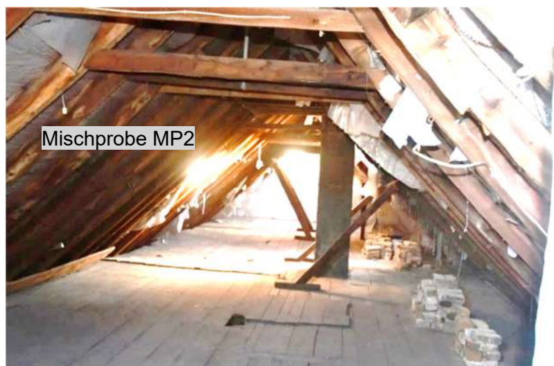
Bild 23: Spitzboden Raum Nr. 1, Blickrichtung Süd (23.11.2022)
