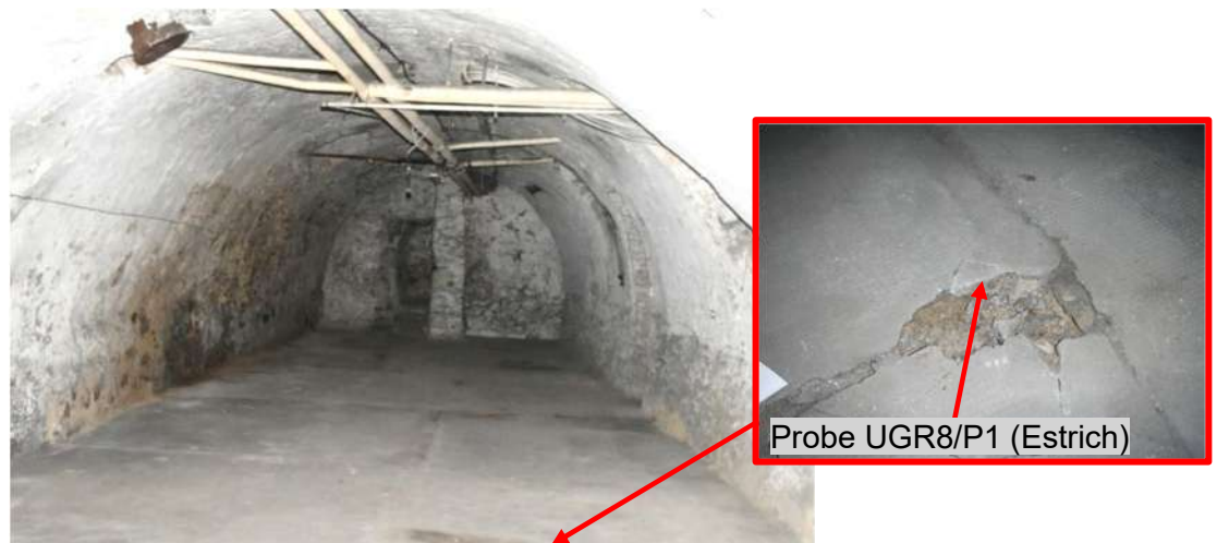
Bild 4: Blick nach Westen in den Kellerraum Nr. 8 (23.11.2022)
