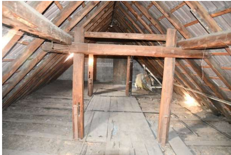
Bild 44: DG Raum Nr. 22, Blickrichtung Süd (23.11.2022)
