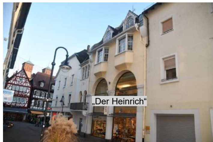
Bild 24: „Der Heinrich“, Blick nach Südosten (23.11.2022)
