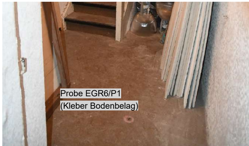
Bild 41: EG Raum Nr. 6, Kunststofffußboden (23.11.2022)
