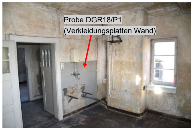
Bild 33: DG Raum Nr. 18, Blickrichtung Nordost (23.11.2022)
