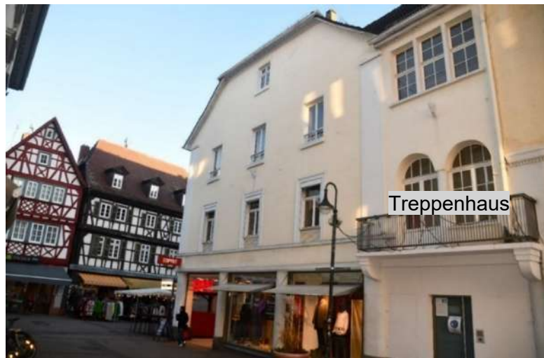
Bild 7: „Die 27“, Blickrichtung Südost (23.11.2022)
