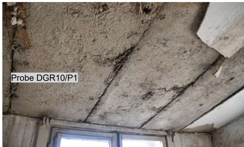
Bild 14: DG Raum Nr. 10, HWL-Platte (23.11.2022)
