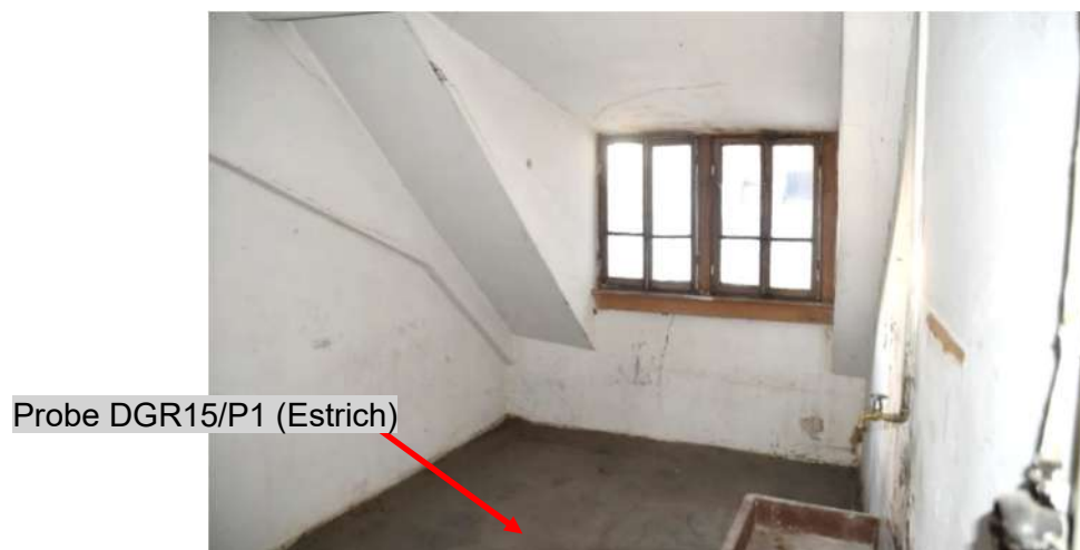
Bild 12: DG Raum Nr. 15, Blickrichtung Südwest (23.11.2022)
