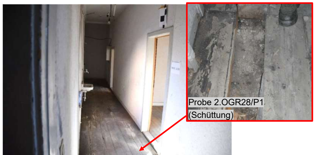
Bild 40: 2.OG Raum Nr. 28, Blickrichtung Südwest (23.11.2022)
