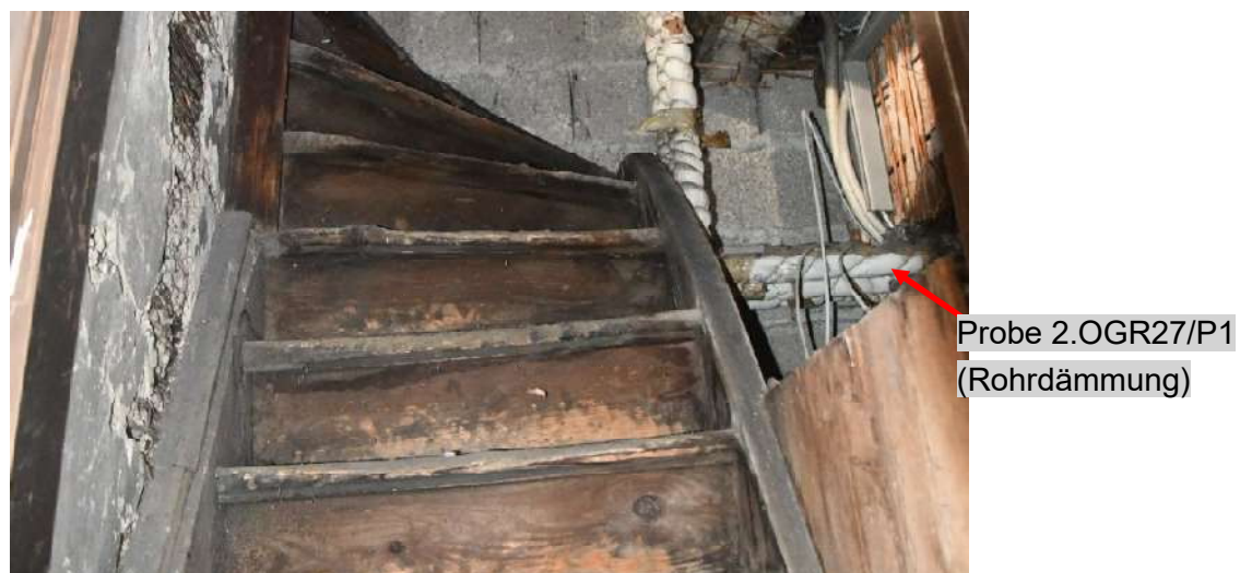
Bild 43: 2. OG Raum Nr. 27, Blickrichtung Nord (23.11.2022)
