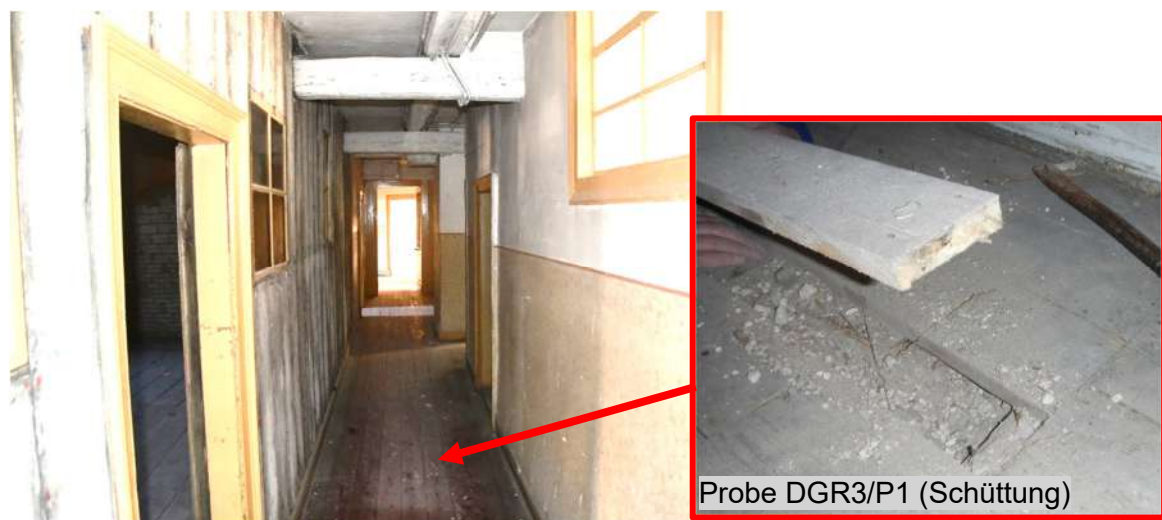
Bild 15: DG Raum Nr. 3, Blickrichtung Süd (23.11.2022)
