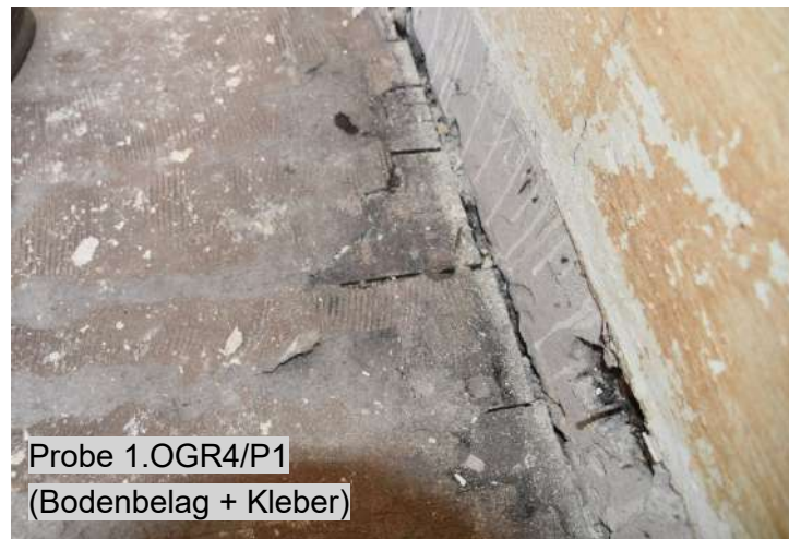
Bild 16: 1. OG Raum Nr. 4, Reste eines Bodenbelags (23.11.2022)
