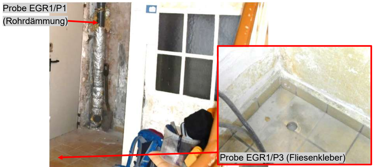
Bild 17: EG Raum Nr. 1, Blickrichtung Südost (29.11.2022)
