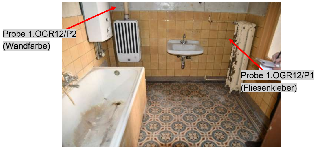
Bild 19: 1. OG Raum Nr. 12, Blickrichtung West (23.11.2022)
